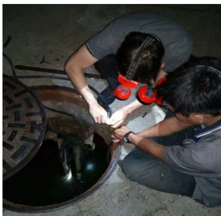
รูปที่ 4.7 ตรวจสอบเช็คสายไฟที่ขาด
