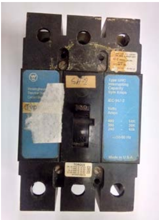
รูปที่ 4.3 ตรวจเช็คเบรกเกอร์ใช้คลิปแอมป์เช็คการทำงานสามารถตัด-ต่อกระแสไฟฟ้าได้
