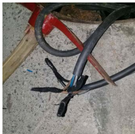
รูปที่ 4.8 เปลี่ยนสายไฟและตัดต่อสายจุดที่ชื้อค
