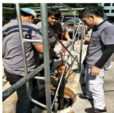
รูปที่ 4.8 เปลี่ยนสายไฟและตัดต่อสายจุดที่ชื้อค
