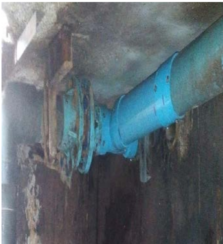
รูปที่ 4.15 ตัดต่อท่อส่งน้ำเสีย
