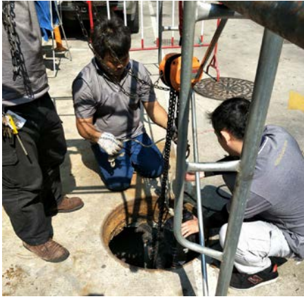
รูปที่ 4.11 ตะขอรอกไปเกี่ยวกับตะขอมอเตอร์ปั๊ม
