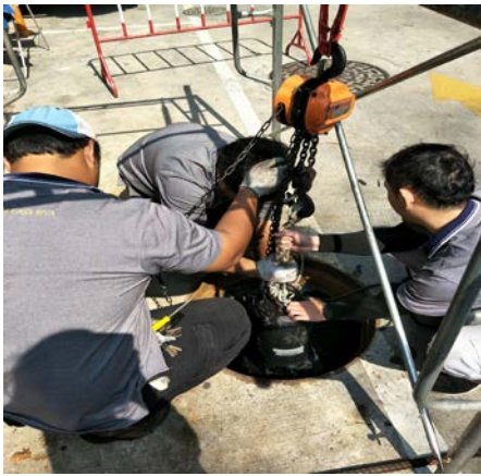
รูปที่ 4.13 นำมอเตอร์ปั๊มขึ้น
