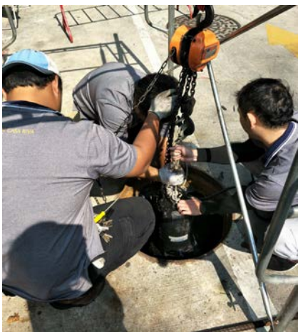
ยกมอเตอร์ปั้มน้ำข้อต่อ
