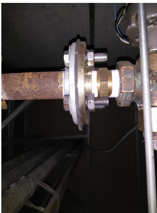
รูปแสดงการแก้ไขแบบใช้ปะเกนมาคั่นกลางระหว่างหน้าสัมผัสของโลหะสองชนิด
