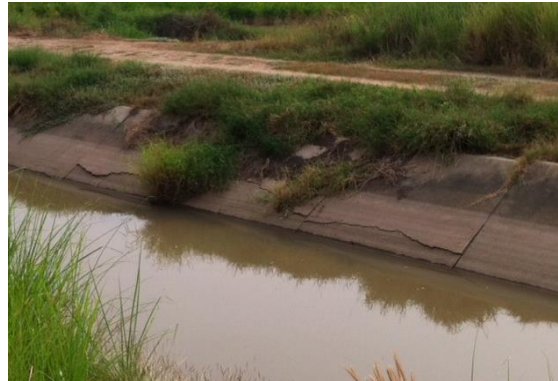
รูปที่ 2.6 งานขุดลอกตะกอนดินคลองส่งน้ำ และคลองที่มีวัชพืชและการแตกร้าตามผนังคลอง
