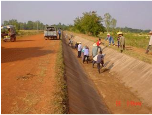
รูปที่ 2.6 งานขุดลอกตะกอนดินคลองส่งน้ำ และคลองที่มีวัชพืชและการแตกร้าตามผนังคลอง
