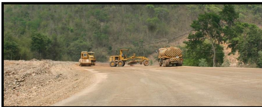
รูปที่ 1.1 การบดอัดดินและปรับหน้าดินก่อนมีการเทคอนกรีตหรือราดยางมะตอยเพื่อทำถนน
