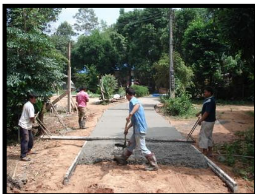
ก. ถนนคอนกรีต
