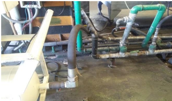
รูปที่ 10 การต่อสายระบบการทำให้สุญญากาศออกจากแม่พิมพ์
