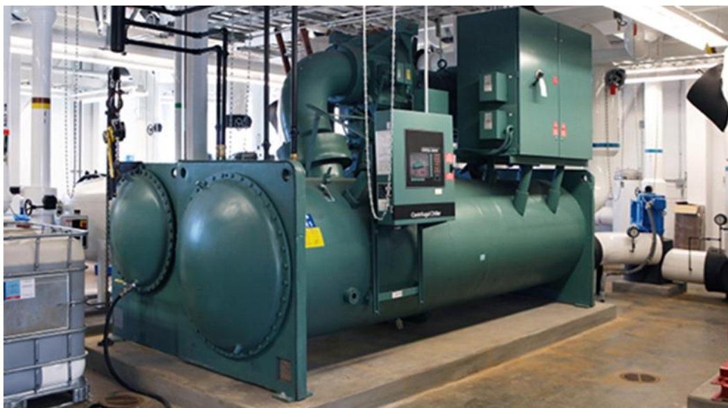
รูปที่ 1.3 เครื่องทำน้ำเย็น (Chiller) ที่ทำการศึกษาวิจัย
