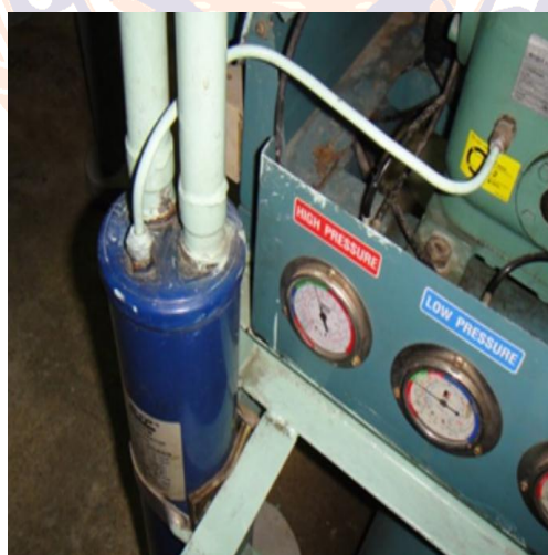
รูปที่ 2.12 อุปกรณ์แยกน้ำมันหล่อลื่น (Oil separator)
