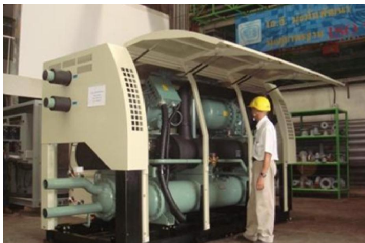
รูปที่ 2.16 เครื่องทำน้ำเย็นระบายความร้อนด้วยน้ำ
