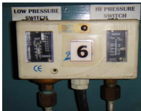
รูปที่ 2.13 สวิตช์ควบคุมความดัน (Pressure Switch)
