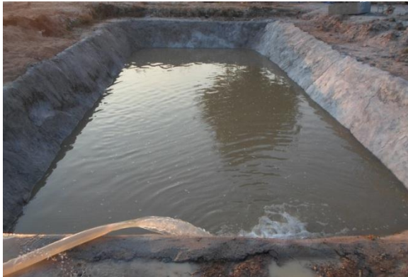
รูปที่ 11 สระน้ำที่ลาดด้วยดินซีเมนต์ผสมน้ำยางพารา
