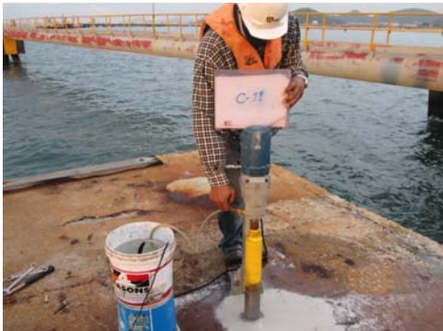
รูปที่ 2 เจาะเก็บตัวอย่างแท่งคอนกรีตด้วยวิธี Coring
