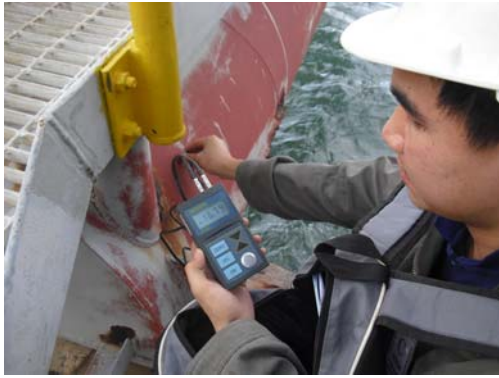
รูปที่ 7 ตรวจสอบความหนาเหล็ก Steel Thickness
