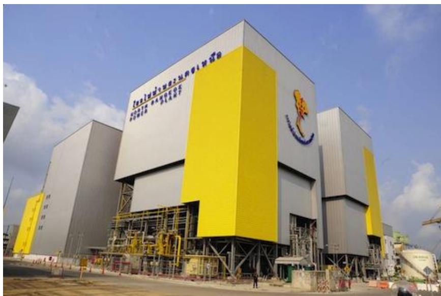
รูปที่ 3.3 โรงไฟฟ้าพระนครเหนือ
