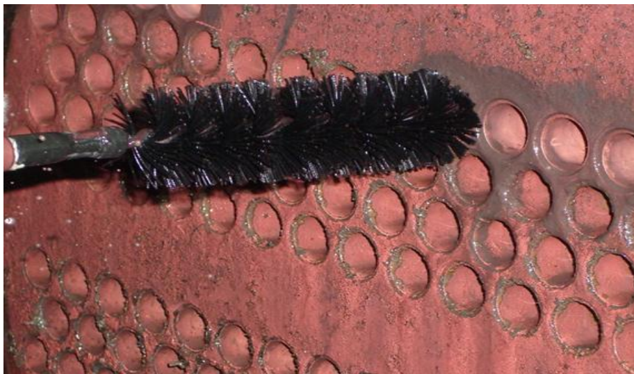
รูปที่ 4.1 รูปการทำความสะอาด Chiller
