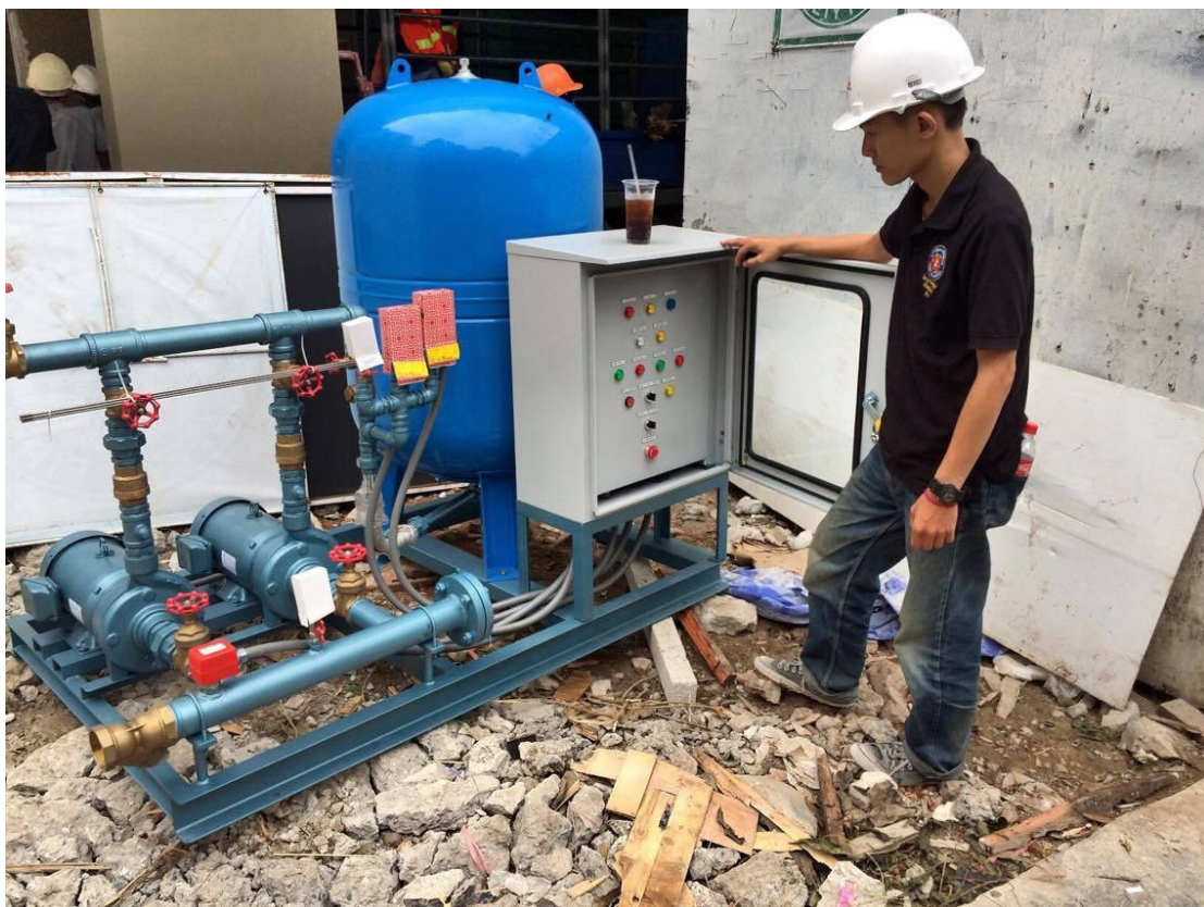
รูป ก การตรวจสอบระบบไฟและสวิชต่างๆ
