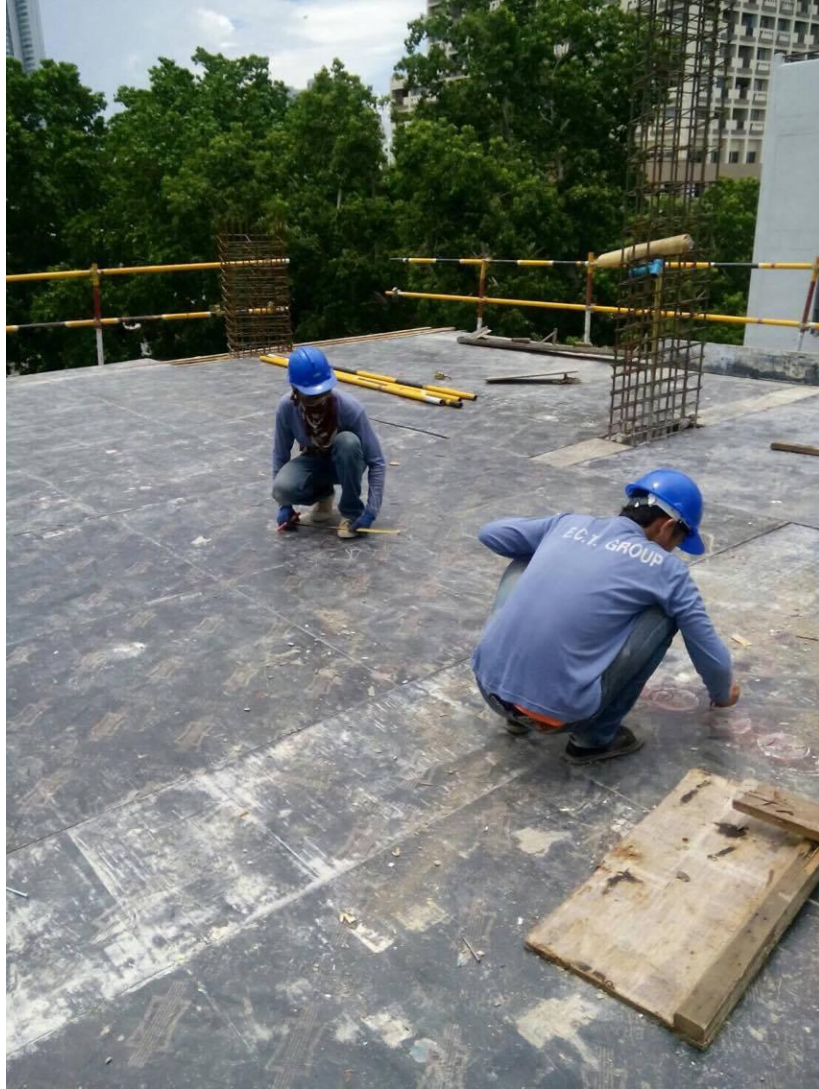
รูป ข การวัดขนาดเพื่อติดตั้ง ท่อ สตีฟ
