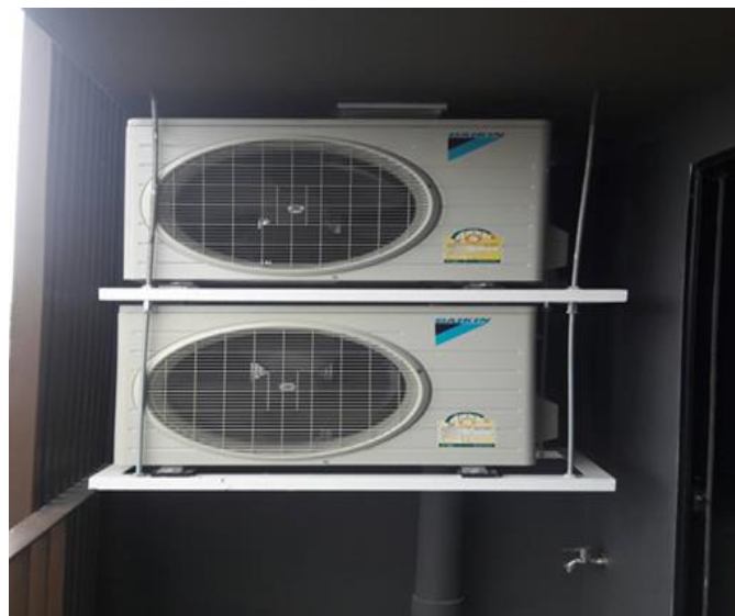
รูปที่ 2.1.4 การติดตั้งคอยล์ร้อน
