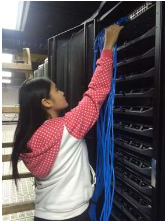
รูปที่ ข.4 เสียบสายแลนเข้าสวิตช์
