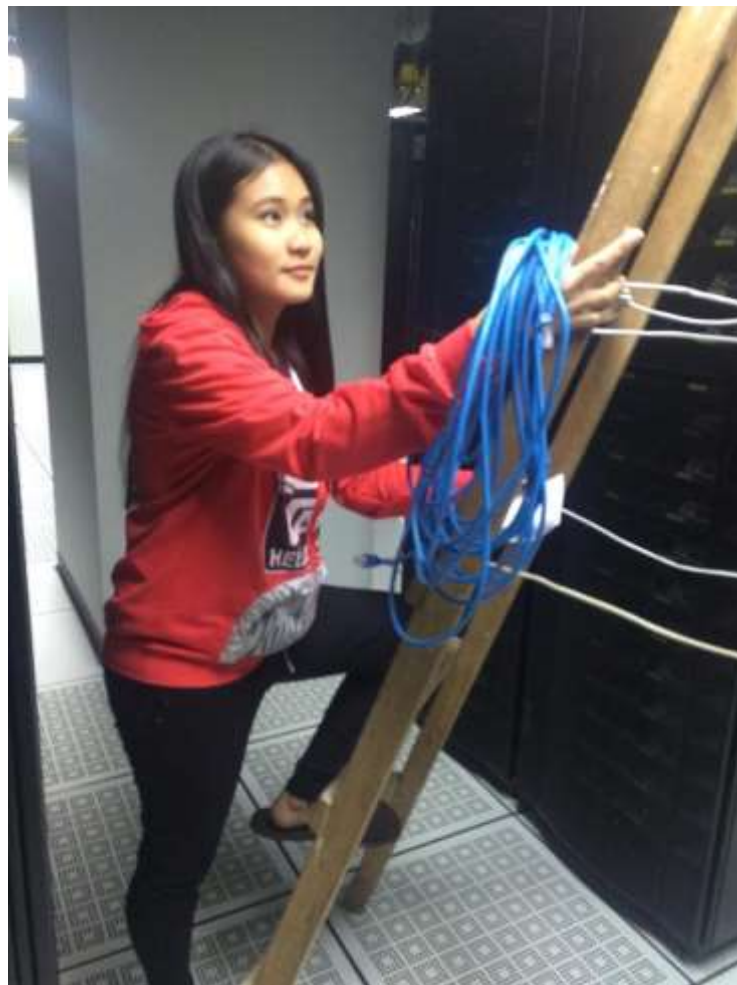
รูปที่ ข.3 วางสายแลนบนตู้เครื่องเซิร์ฟเวอร์
