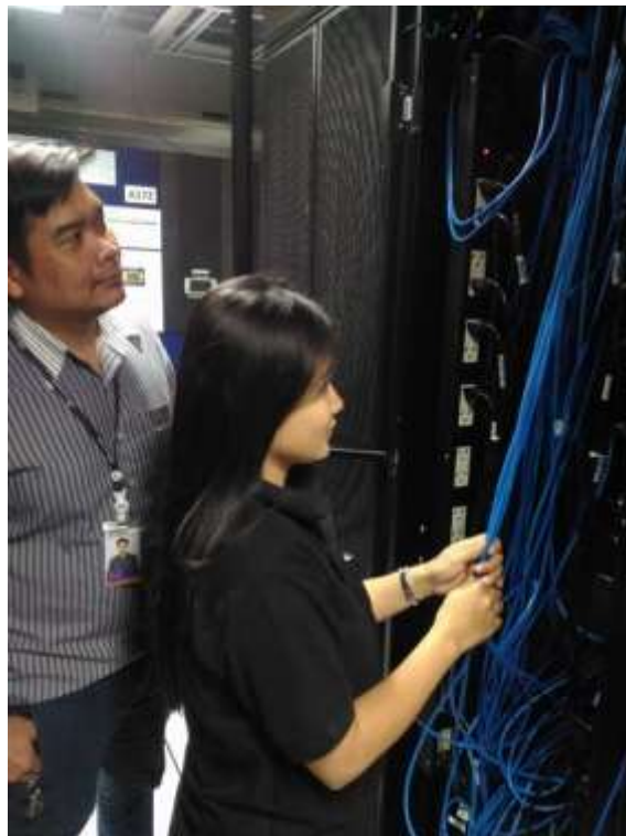
รูปที่ ข.5 จัดสายแลนให้เป็นระเบียบ
